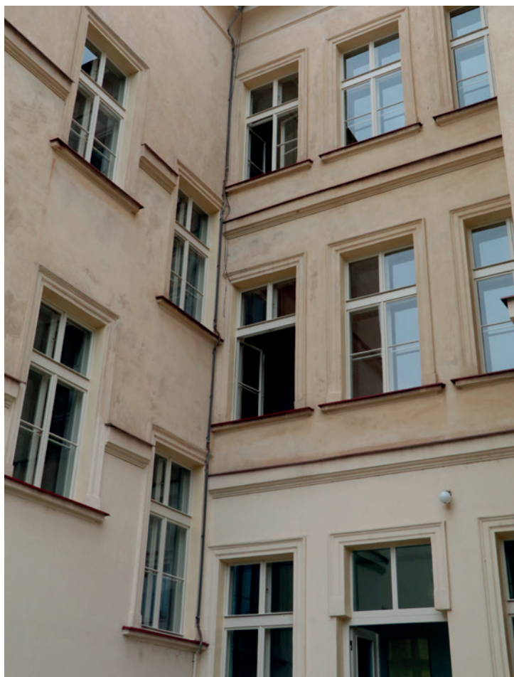
Nová okna na školní budově druhého stupně
