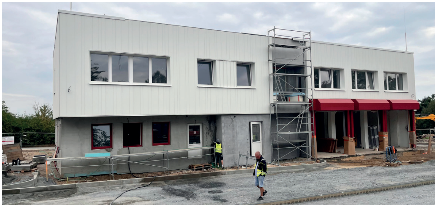
Levá horní část budovy patří záchrance.
